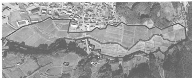
[写真-1] 航空写真撮影した3号工事の完成後
