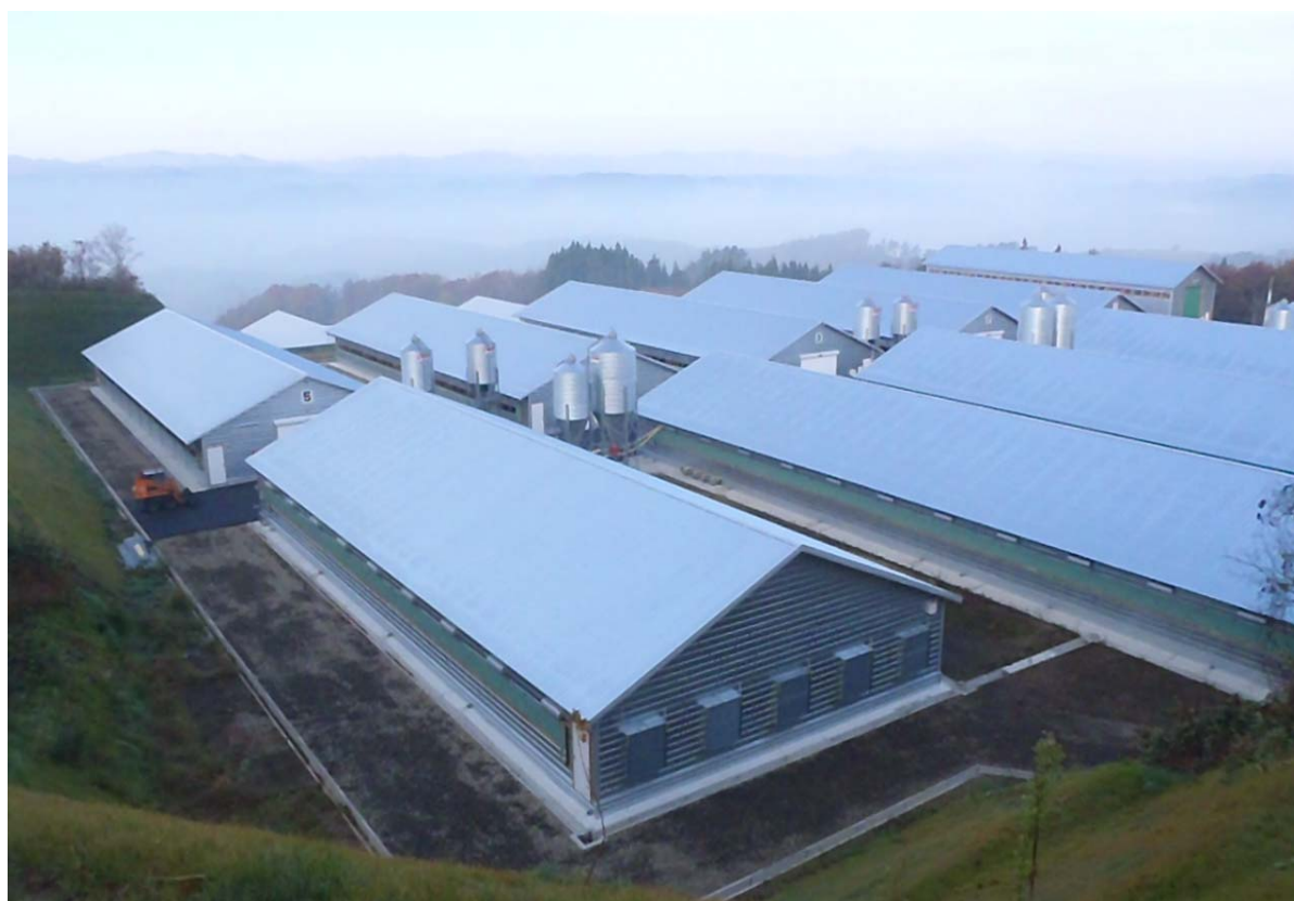
ほたる第一ファーム鶏舎新築工事 2014.10 竣工 499.72㎡×6 棟 751.11㎡×2 棟 596.79㎡×1 棟 489.60㎡×1 棟
